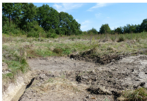
Mare curée et fossé d'évacuation restauré
